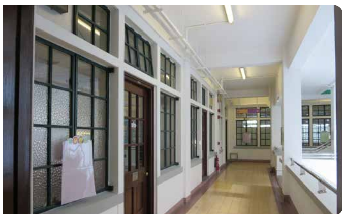
▲ 圖11. 遮風擋雨的走廊，欄河上和窗緣上的斜面設計，以及地面的凹槽皆有助去水，磨砂玻璃窗既能採光又能阻隔視線，上懸窗和平開窗有助空氣對流，地腳牆面和地面的水磨石面防塵防滲。
