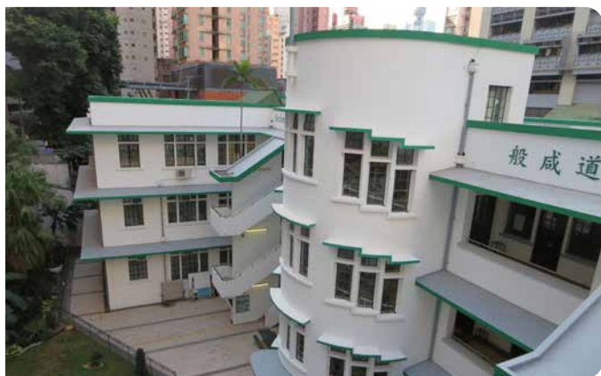
▲ 圖9. 校舍整體呈流線型，著重功能：白牆面以綠/灰藍線點綴，橫向鐵框長窗以上懸窗和平開窗組成，開放式走廊，傾斜的雨篷、窗緣和欄河頂，水泥倒模的接水漏斗，外窗顯示上落方向的螺旋樓梯，藏於梯頂房間的水箱，旗桿，兩條1975年加建的開放式樓梯。
