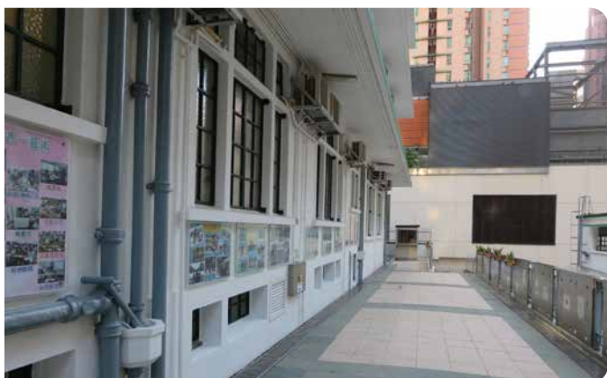
▲ 圖10. 傾斜的雨篷和窗緣，橫向大鐵窗，磨砂玻璃，防彈室通風口，水泥倒模的接水漏斗。
