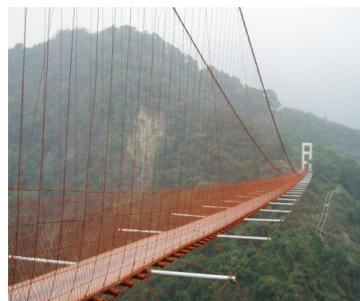
图六、茂林高吊桥桥面
