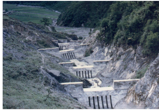
图片 6 九寨沟泥石流防治工程——拦沙坝群
