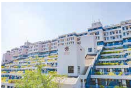
Grantham Hall 葛量洪堂 Area 面積: 7,945m 2
